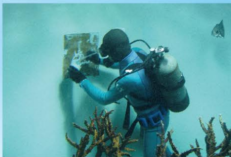
水族館水槽内防水塗装補修施工例 観賞用水槽・養殖場の水中防水塗装ができます。
