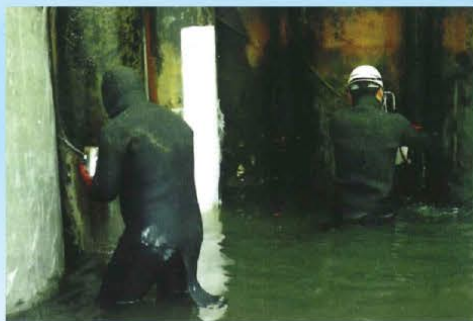
鋼管杭 防食補修施工例 海中や淡水中の鋼管杭・栈橋・鋼板・海洋構造物等港湾設備の海中部分やダム・用水路・水門等の設水部分の防食処理が出来ます。
