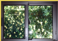
窓枠などの隙間
