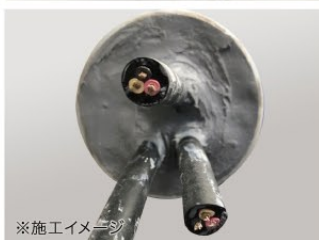
※施工イメージ
